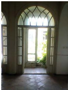
شکل ۹: منعطف بودن پنجره‌های دوپوسته و تهویه‌ی هوای مستقیم به فضا در تابستان (نگارنده)
