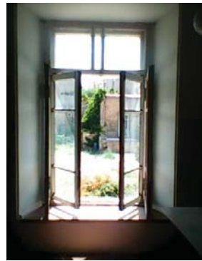
شکل ۹: منعطف بودن پنجره‌های دوپوسته و تهویه‌ی هوای مستقیم به فضا در تابستان (نگارنده)
