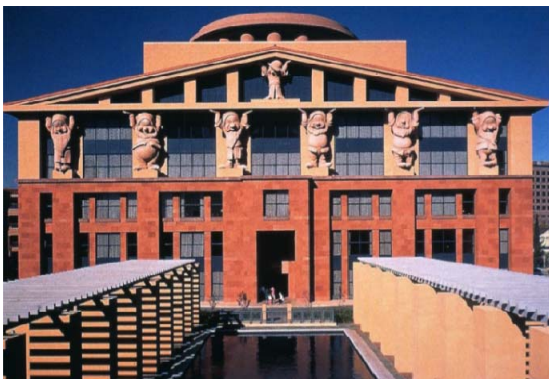
تصویر: ساختمان تیم دیزنی اثر مایکل گریوز در کالیفرنیا (۹۱ - ۱۹۸۵)
