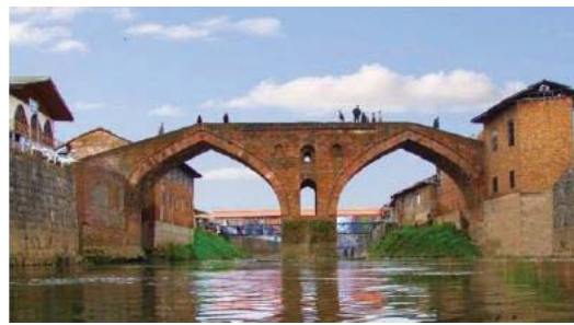
شکل ۱. پل خشتی لنگرود
