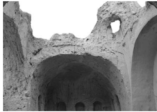
تصویر ۱۷. گوشه‌سازی دروازه جنوبی کوه خواجه با باریکه تاق در سال ۱۹۲۹ میلادی (مأخذ: ارنست هرتسفلد)
